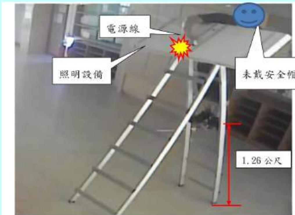
照片 | 蕭員拔除照明設備電源時發生感電墜落。(監視器截錄畫面)
