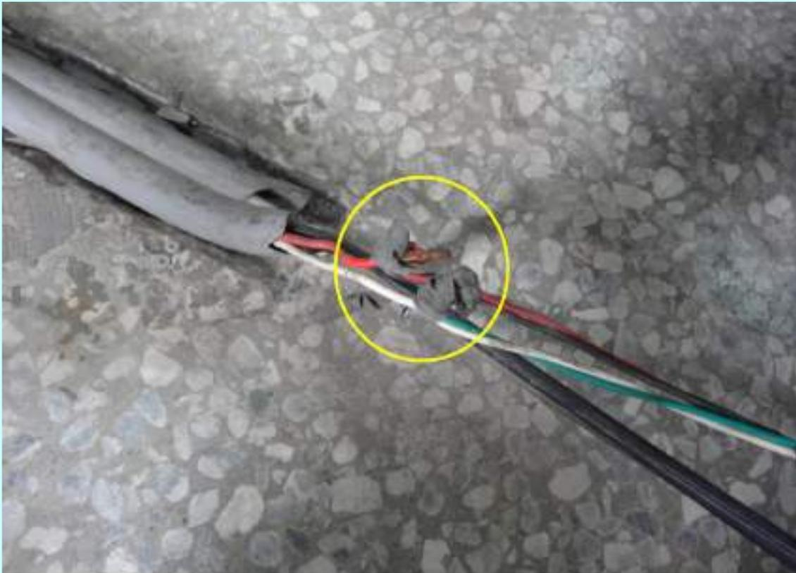
照片 2 地面插座電線裸露之情形
