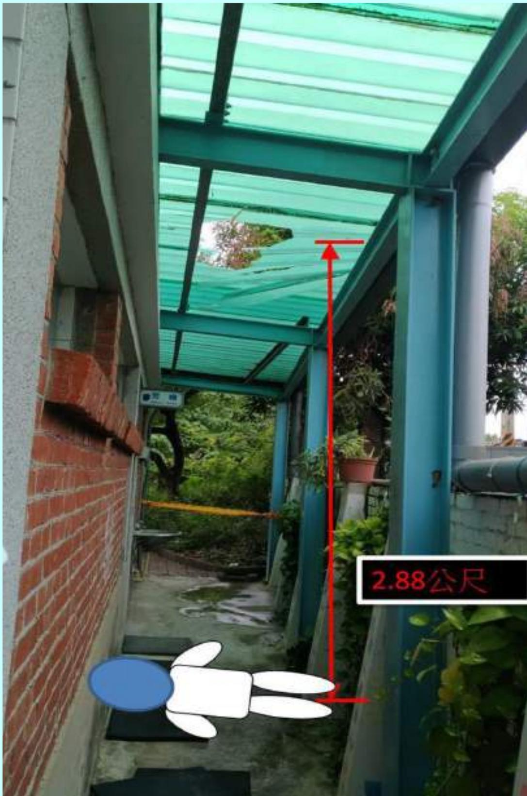
罹災者踏穿塑膠採光罩後，自2.88公尺高處墜落至地面
