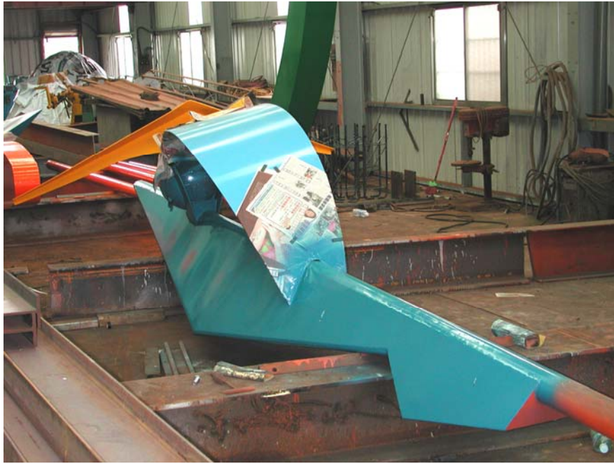
製作過程照片：現場
