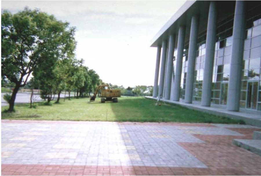
製作過程照片：現場
