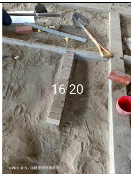
紅磚路緣施作
