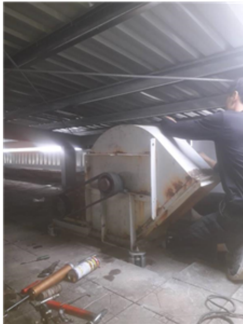
廢氣排除設備
