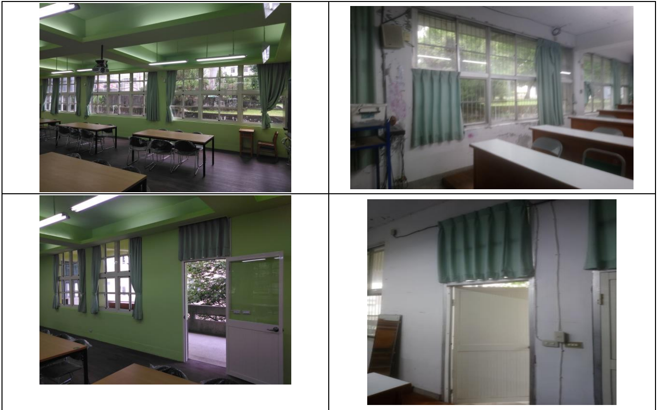
(二)電力電源設置改善：重新佈線。
