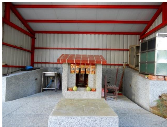
照片 22 祠室外牆米白色瓷磚改為洗石子
