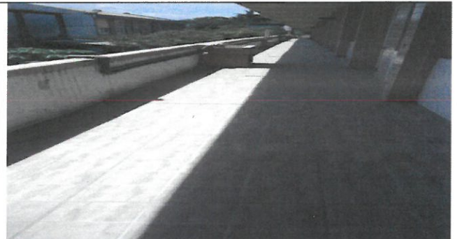
實習工廠走道鋪設防滑地板
