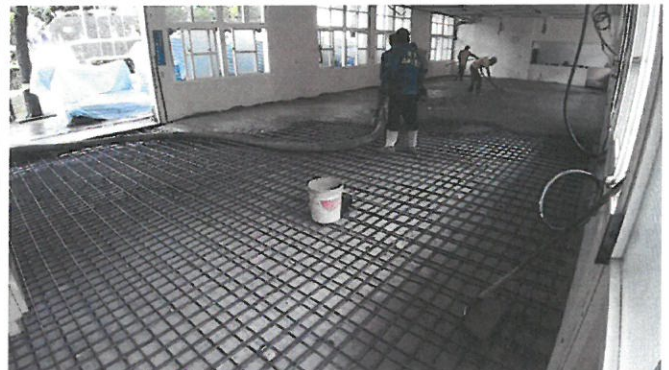
CNC 車床新設撲面施工
