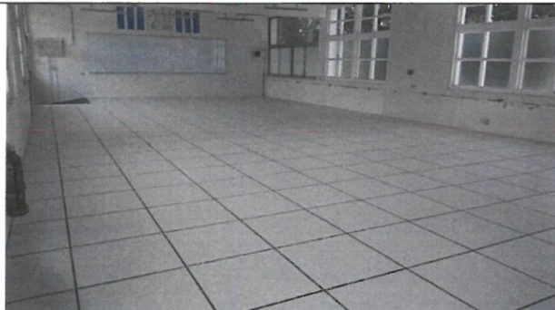
繪圖教室鋪設高架地板
