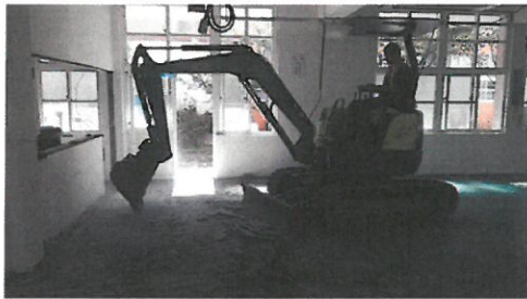
CNC 車床舊有撲面移除
