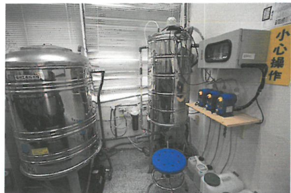
圖 2 植物工廠管線水槽雜亂，且具工安危險。
